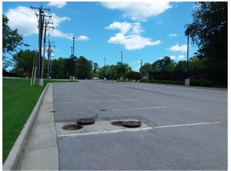
BMP 40- outlet manholes
